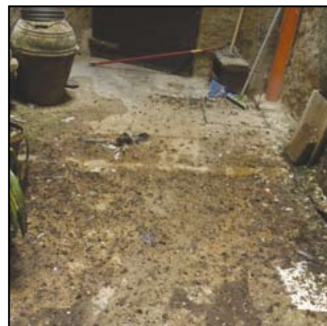
Interno di un'abitazione non utilizzata in periodo invernale
